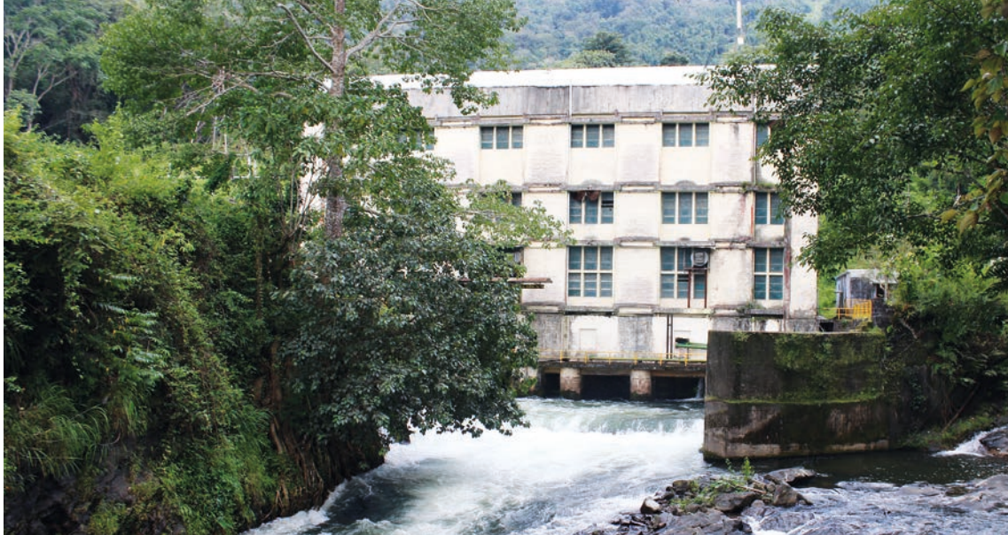
Casa de força e rio Sholayar
