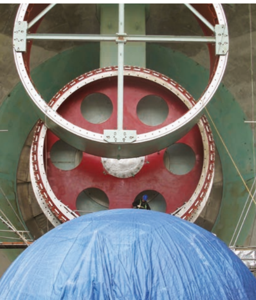
Instalação da peças de turbina Bulbo na UHE Sihwa, Coréia do Sul
