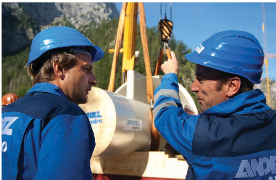
Time ANDRITZ HYDRO durante a instalação da turbina Bulbo
