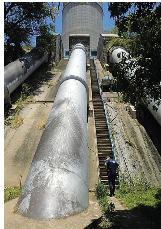
Condutos forçados antes dos trabalhos de reabilitação
