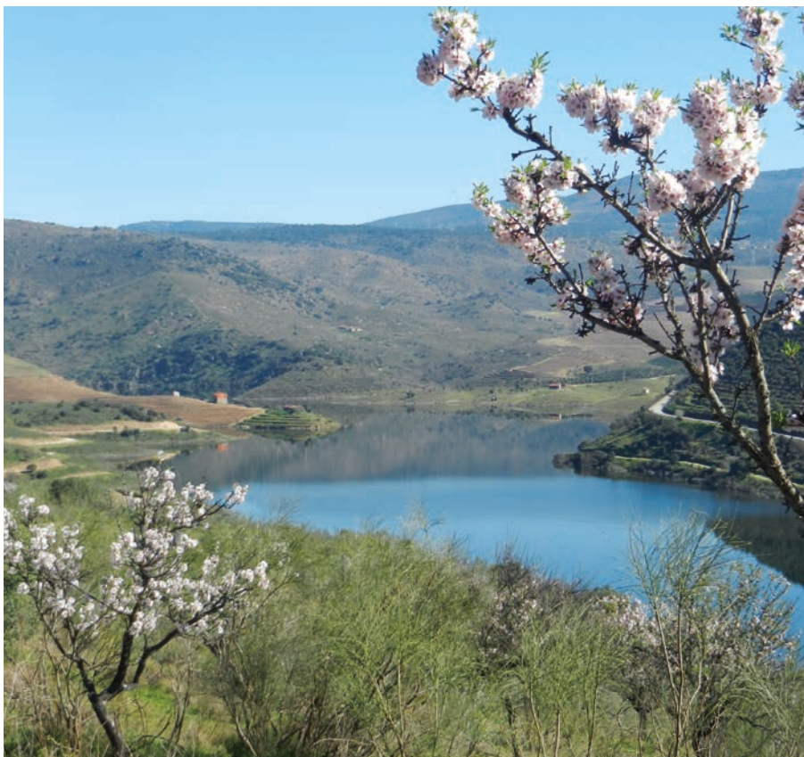
Reservatório do estágio Jusante
