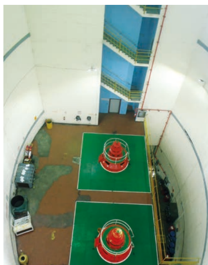
Prédio da UHE Centroamérica
