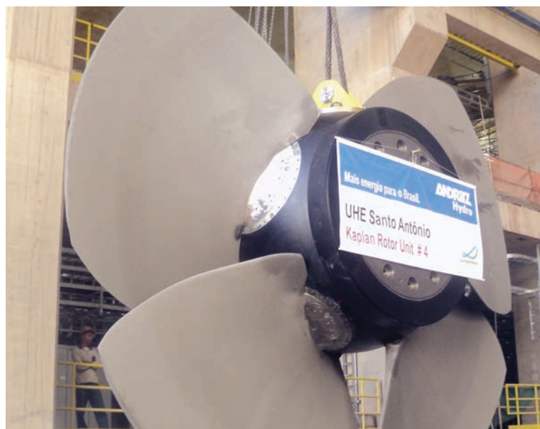
Instalação de turbinas Bulbo na UHE Santo Antonio, Brasil
