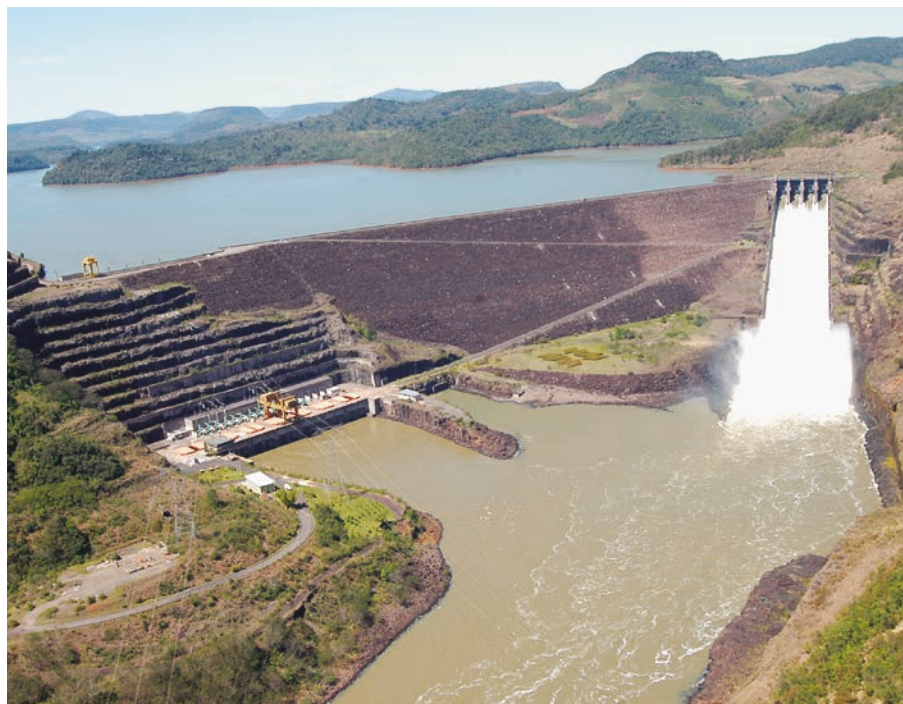
Vista a jusante da casa de força, barragem e canal de descarga
