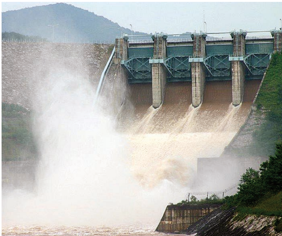
Reservatório e vertedouro
