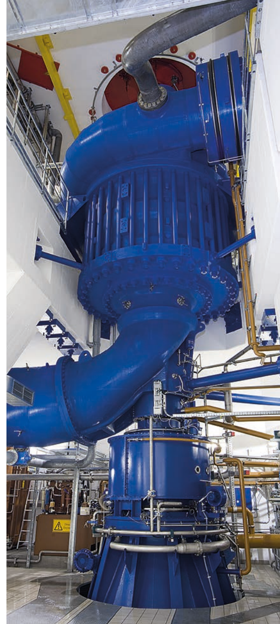
Unidade turbina-bomba com quatro estágios
