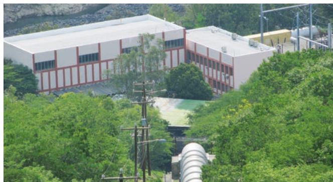
Casa de força e conduto forçado existentes na UHE Carlos Fonseca
