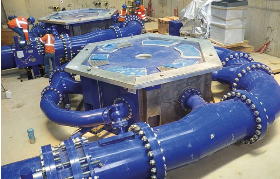
Instalação de gerador na UHE El Carmen
