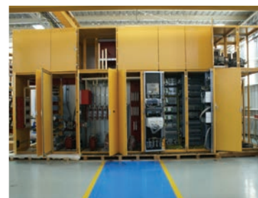
Симон Боливар, Венесуэла 805 МВА; большая система возбуждения; самый высокий уровень напряжения, решение THYNE 6
